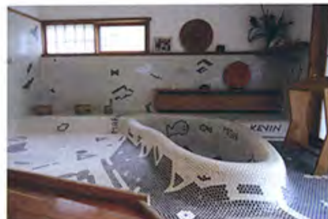
写真6: 応接棟のモザイクタイルを貼った埋め込み式浴槽
